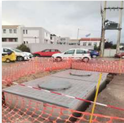
Εικόνα 7: Τοποθέτηση Υπόγειων Κάδων
